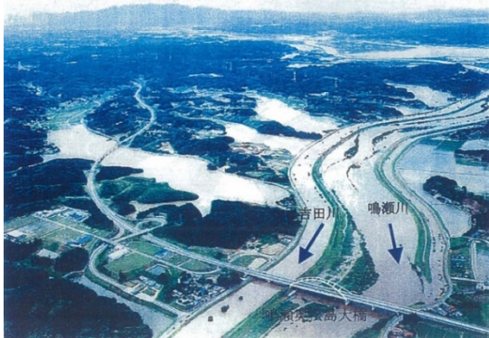
平成14年7月洪水時の出水状況 (鳴瀬川・吉田川下流の浸水状況) (写真奥に見えるのが品井沼遊水地一帯)
