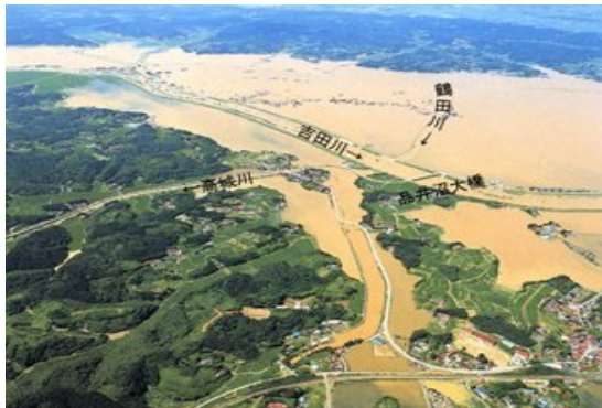
昭和61年8月洪水時の出水状況 (高城川及び鶴田川、吉田川の浸水被害状況)
