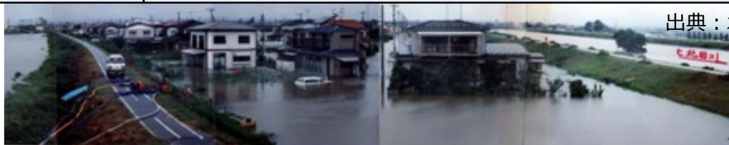
昭和61年8月洪水時の出水状況 （仙台市宮城野区梅田川合流点付近）
