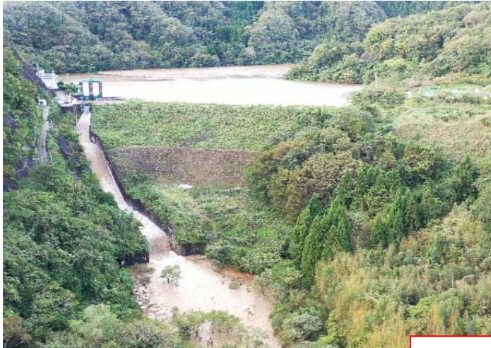
写真：樽水ダムの状況
