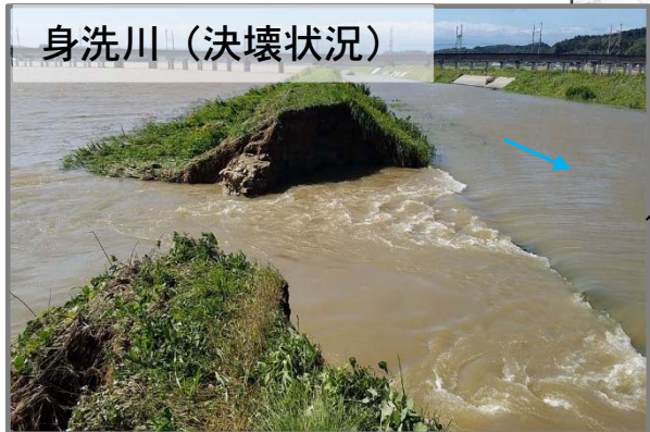
図：台風第19号による宮城県管理河川の堤防決壊箇所
