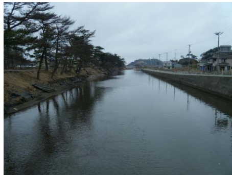
(2012年4月) 工事着工前の状況
