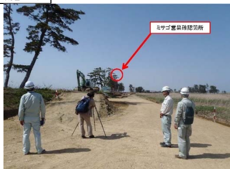
環境アドバイザーによる現地確認
