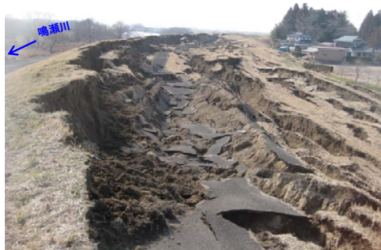
写真 2-25 鳴瀬川左岸 30.3k 付近
