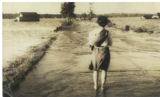
写真 2-5 旧三本木町(大崎市)奥州街道沿いの鳴瀬川に架かる橋梁が水没
