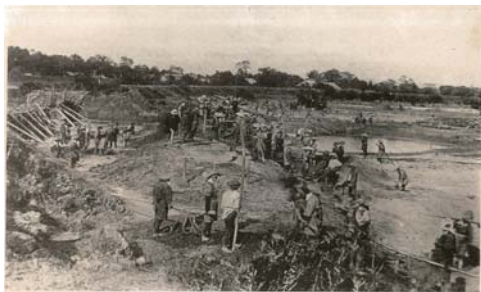
写真 2-3 明治43年8月洪水 鳴瀬川 旧三本木町(大崎市) にて堤防決壊箇所を修復する様子
