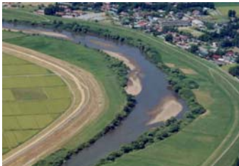
写真 2-32 鳴瀬川の水際の状況
