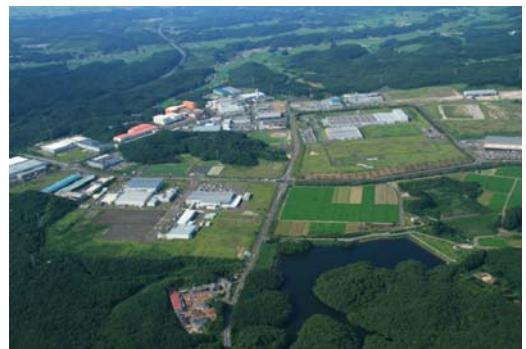
写真 2-10 仙台北部工業団地
