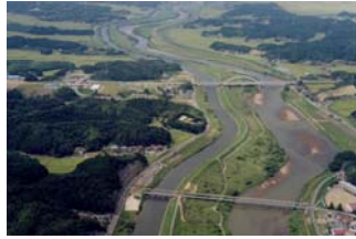
写真 2-28 背割堤の状況
