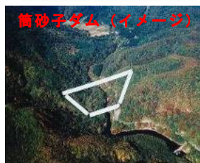
筒砂子ダム (イメージ) 宮城県 (建設中)
