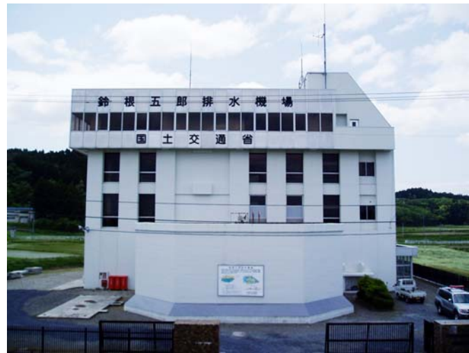
写真 4-3 鈴根五郎排水機場（鳴瀬川）
