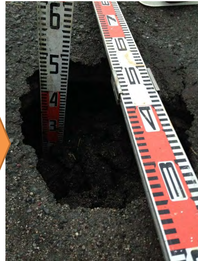
アスファルト舗装の陥没を発見 半径:約50cm 深さ:約50cm(H27.9.1)
