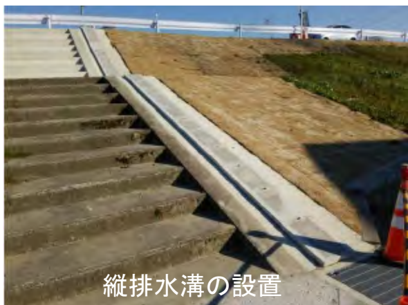
のり面の表面を押さえるように施工
