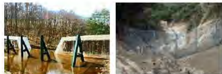
・後付式の流木補足工や強靱ワイヤーネットを活用した緊急整備
