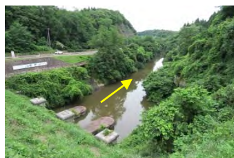
高城川中流部 高城川トンネル出口から下流を望む
