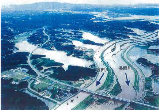
鳴瀬川・吉田川下流の浸水状況 (写真奥に見えるのが品井沼遊水地一帯)
