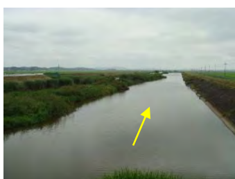
鶴田川下流部 鶴田大橋から下流を望む
