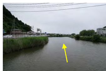
高城川中流部 愛宕橋から下流を望む
