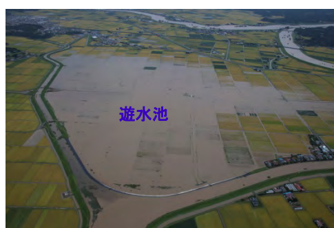
品井沼遊水地への越流状況 (H27.9.11)
