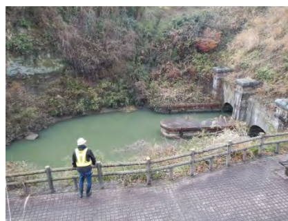
河川巡視の状況
