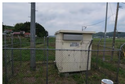
鶴田崎水位観測所
