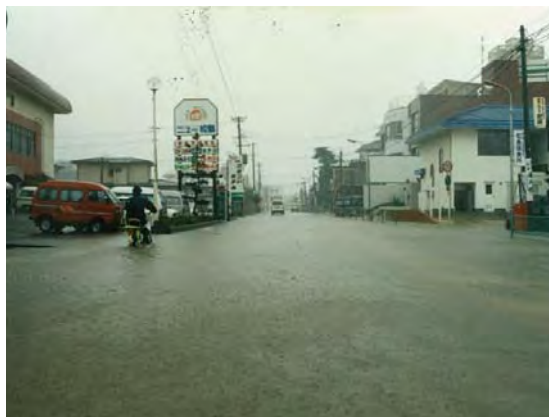
高城川右岸堤内地の浸水被害状況
