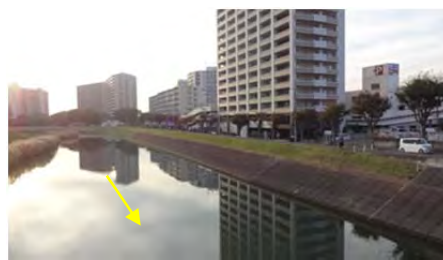
砂押川下流部 鎮守橋より上流を望む
