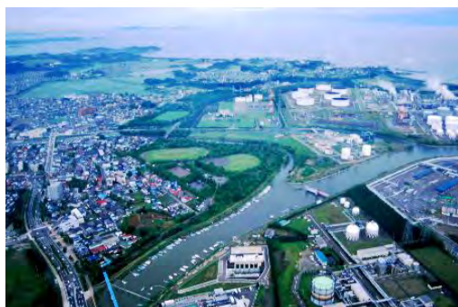
仙台港多賀城地区緩衝緑地
