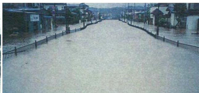
多賀城市内 道路冠水
