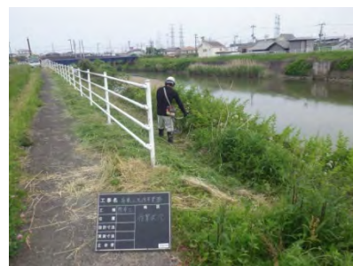
堤防除草の状況（砂押川）
