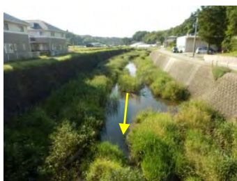
砂押川上流部 高嶋橋より上流を望む
