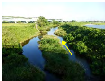
砂押川中流部 新山路橋より下流を望む (右岸に砂押川遊水地)
