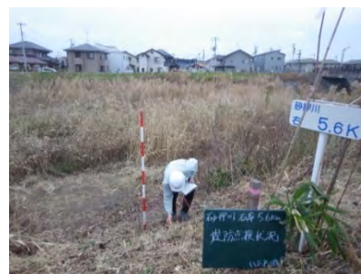
堤防点検の状況（砂押川）
