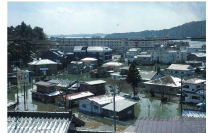
地盤沈下による浸水の様子
