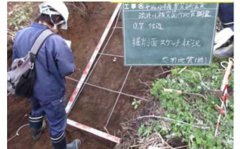
左岸 0.7k+50付近実施状況 14
