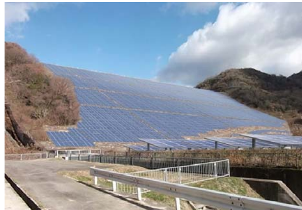
堤体斜面太陽光発電事例(兵庫県)
