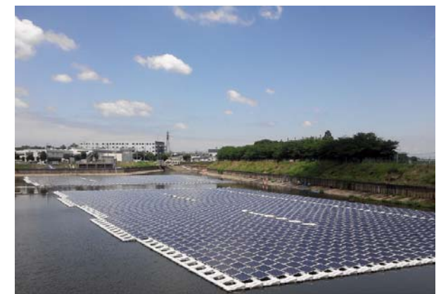
貯水池水面利用太陽光発電事例(桶川市)
