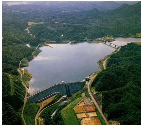
南川ダム(南川)
