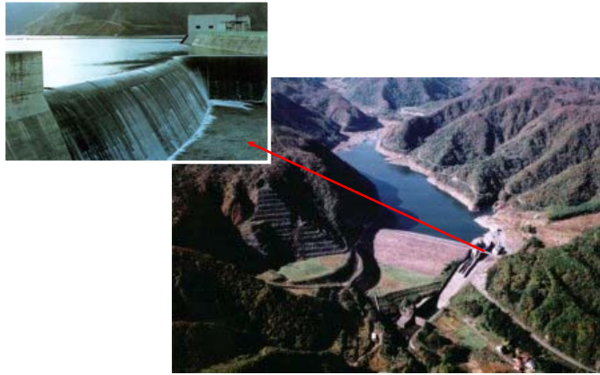
漆沢ダム(鳴瀬川)
