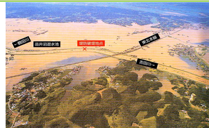
図：吉田川の越水氾濫による被災状況（旧鹿島台町）
