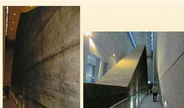
薬品(ポリエチレングリコール)を使用して堤体を固めた、高さ約15m、幅約60mの狭山池堤体断面 上写真は切り出された1400年に及ぶ堤体。
