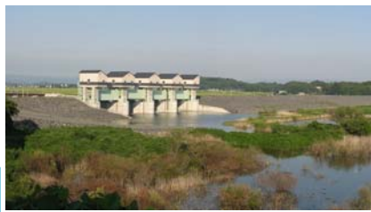
長沼ダム水門（全景）
