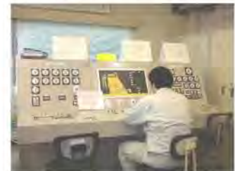
写真 2-10 樽水ダム保守点検
