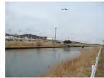
写真2-4 南貞山運河（仙台空港周辺）
