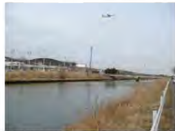
写真2-4 南貞山運河（仙台空港周辺）
