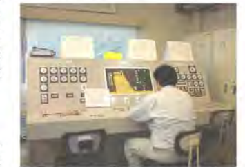
写真 2-10 樽水ダム保守点検
