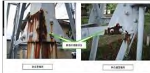
テレメータ・放流警報設備更新
