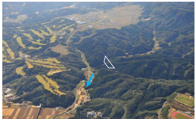
ダム建設予定箇所
