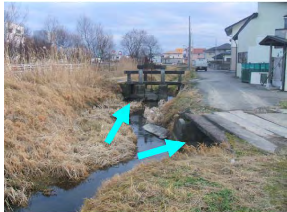
上流分水箇所
