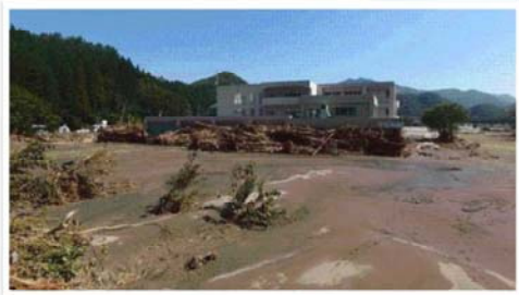
平成28年台風第10号による被害状況
