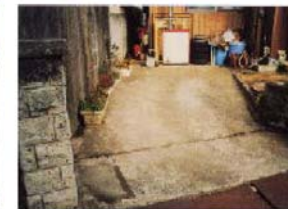
■ 空隙貯留（石油化学製品）
