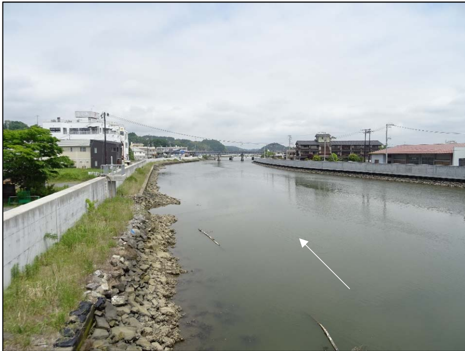
高城川（宮城郡松島町松島地内）
