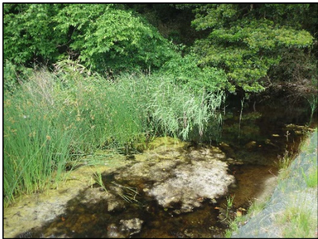
工事終了後の移植地の状況
