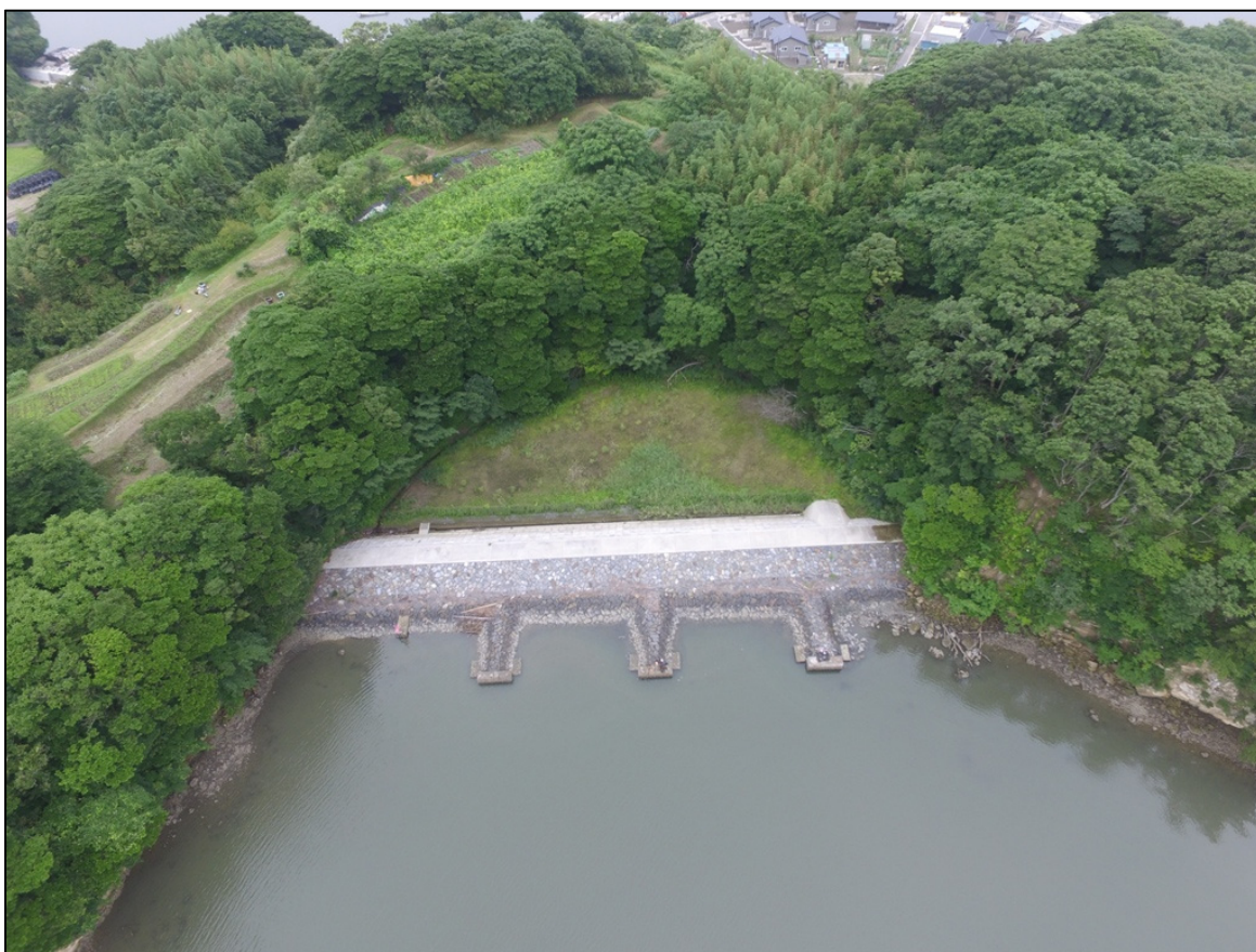
朴島3海岸の状況（令和2年7月20日）
