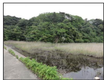
地盤沈下による堤内側の湛水 （朴島4海岸）
