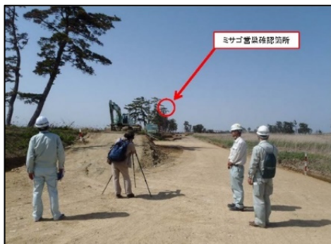
環境アドバイザーによる 現地確認
