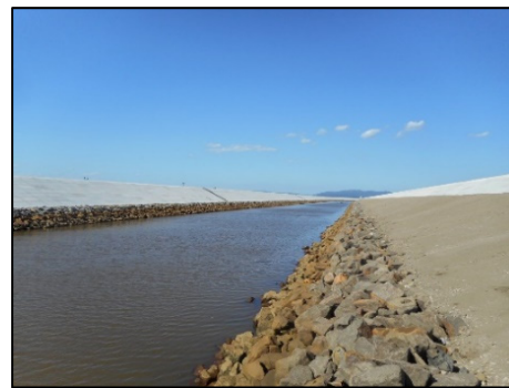
覆土・寄石の実施状況 (平成 28 年 7 月)
