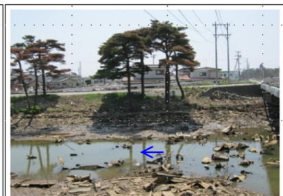
3. 護岸崩壊 タイプC・L=370m
