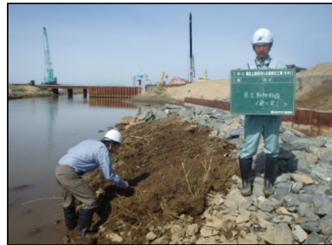
小碎石の敷設状況
