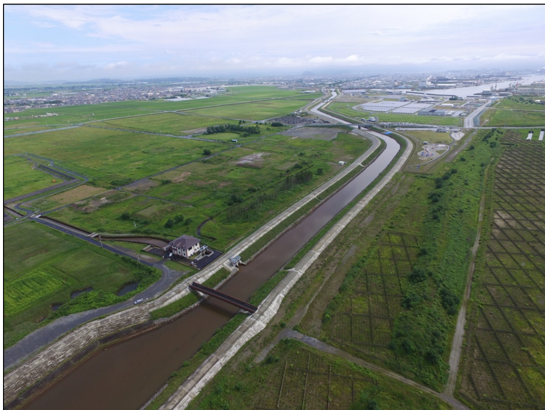
南北上運河（浜須賀橋側）の状況（令和2年7月19日）
