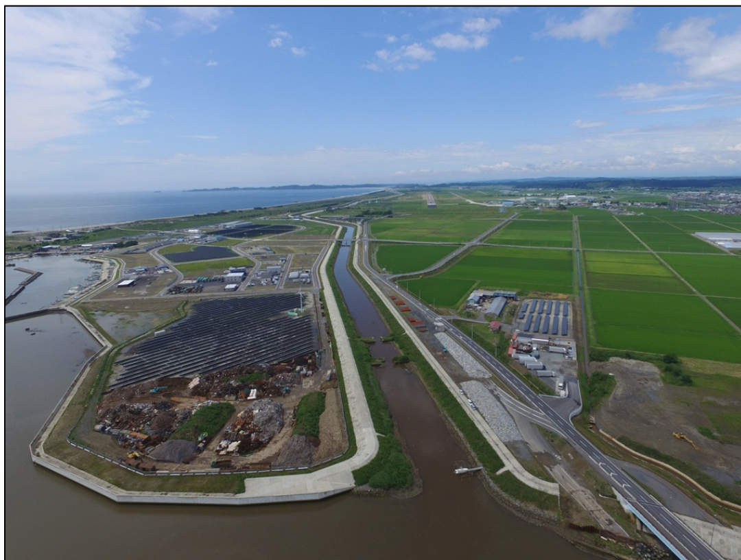
南北上運河（定川側）の状況（令和2年7月19日）
