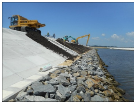
覆土の施工状況 (平成 28 年 6 月)
