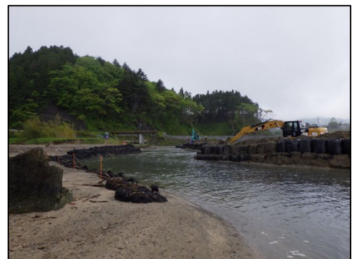
平貝川仮水路の整備状況 （カニ類の産卵ルートの保全）
