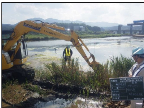
移植作業状況
