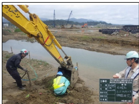
移植作業状況
