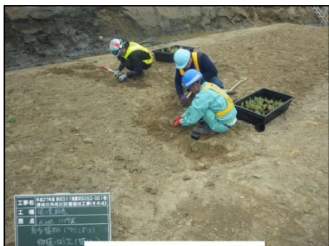
移植作業状況
