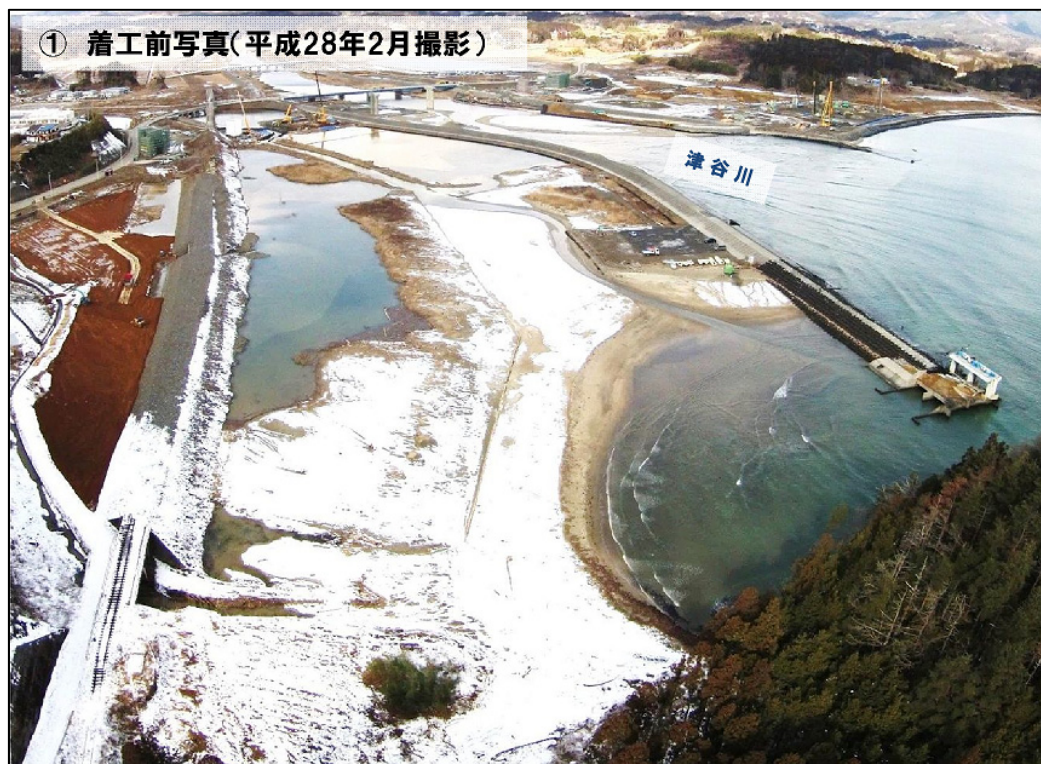
写真 4-2-2 着工前の右岸湿地帯の状況【津谷川】
