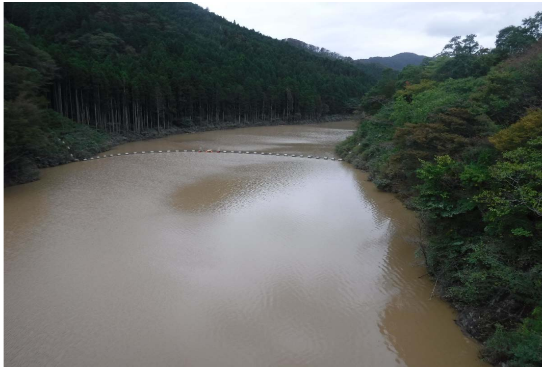
払川ダム湖流入部を臨む（洪水調節後 10月13日）
