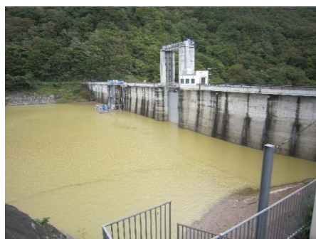
貯水池 ダム堤体上流 (撮影:10月13日9時)
