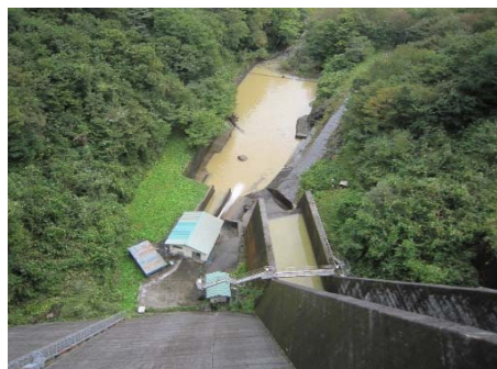
放流設備 ダム堤体下流 (撮影:10月13日9時)
