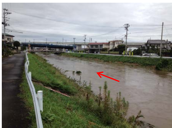
増田川(上増田水位観測所)
