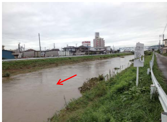
増田川(上増田水位観測所)
