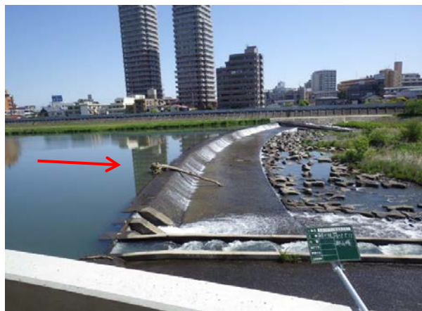
広瀬橋上流部郡山堰(洪水前)
