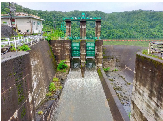
樽水ダム常用洪水吐
