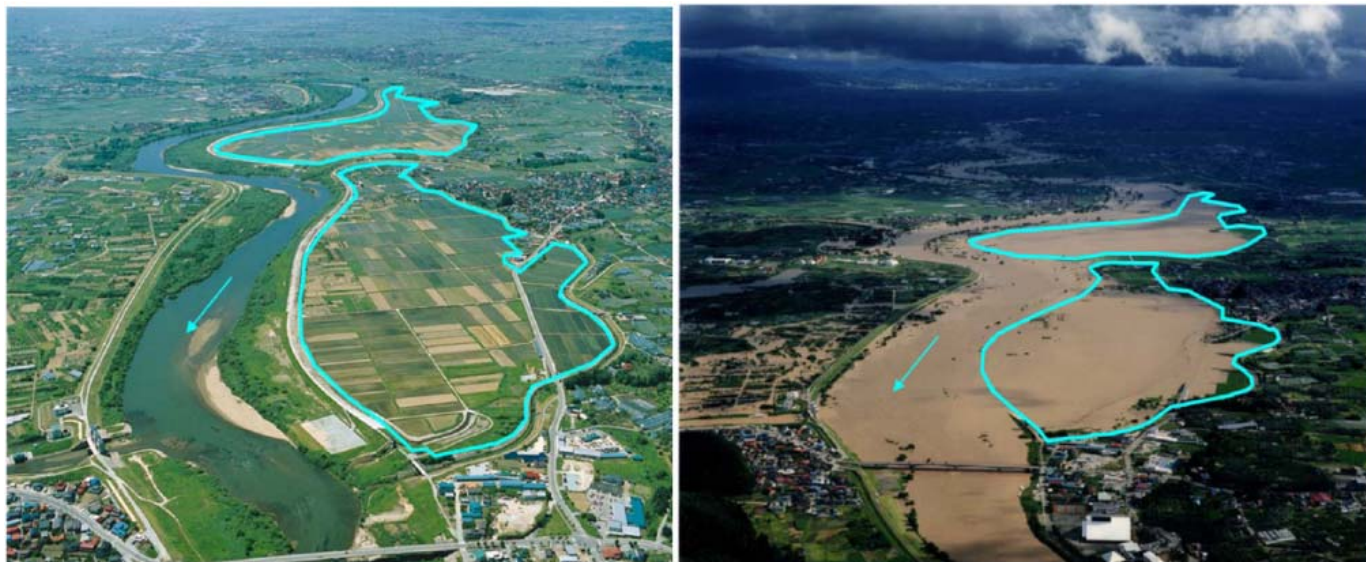
遊水地(平常時) 遊水地(洪水時) 出典：今後の治水対策の在り方に関する有識者会議 第1回会議資料
