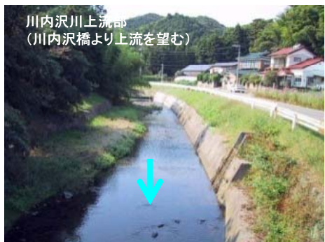
上流部の里山の中を流れており、五分程度の護岸が施されている。
