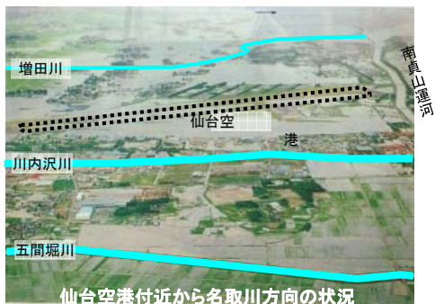
昭和61年8月5日洪水の被害状況写真
