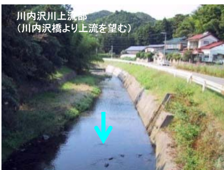
上流部の里山の中を流れており、五分程度の護岸が施されている。
