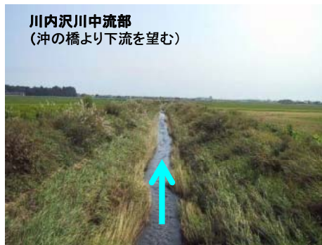
三面張りほぼ直線的な河道であるが、十分に植生が根付いており魚も多くみられる。
