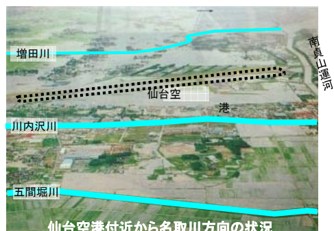
昭和61年8月5日洪水の被害状況写真
