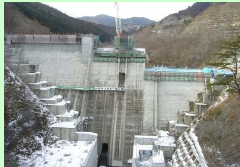
堤体工: 弘川ダム
