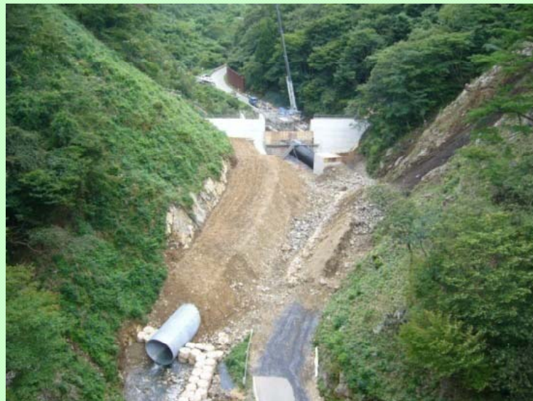
基礎掘削工(土石掘削、岩掘削等): 弘川ダム
