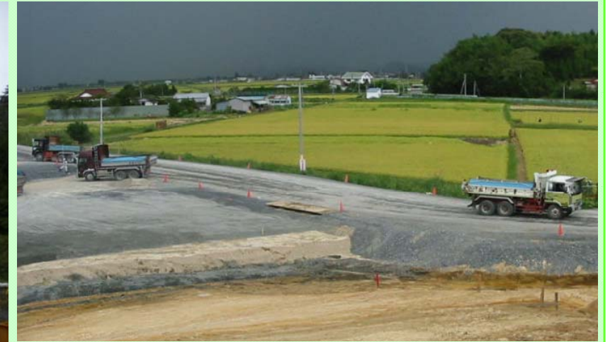
仮設工(工事用道路)
