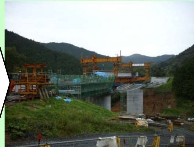
補償工事(付替道路)
