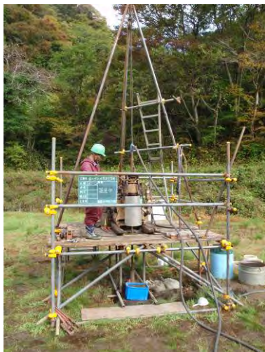
地質調査状況
