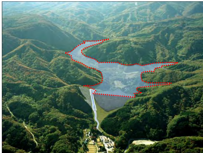
計画湛水区域(下流側より)
