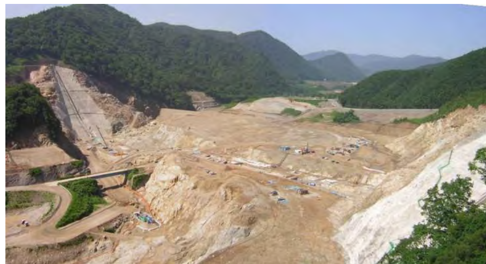
基礎掘削状況(他ダム事例)
