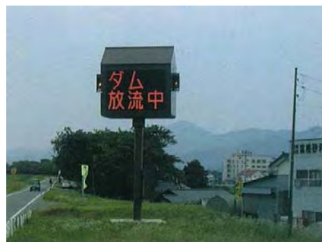
放流警報表示板 (他ダム事例)
