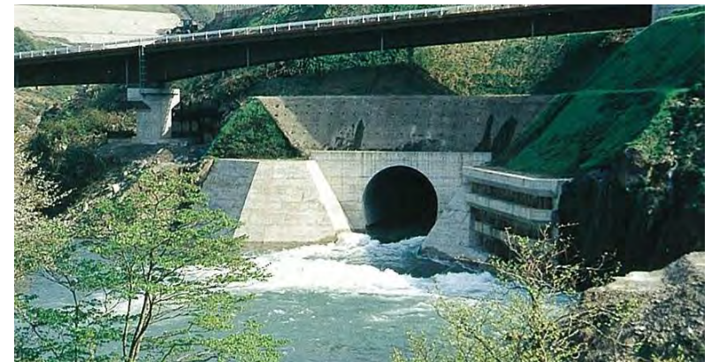
仮排水路トンネル吐口部
