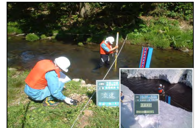
流量観測状況
