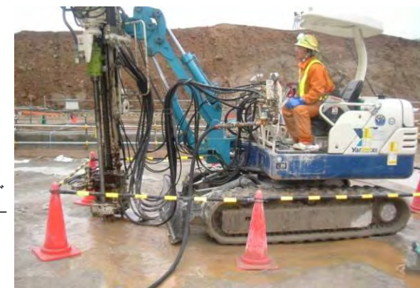
ボーリング状況 (他ダム事例)
