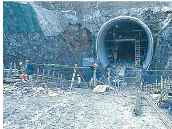
仮排水路トンネル呑口部
