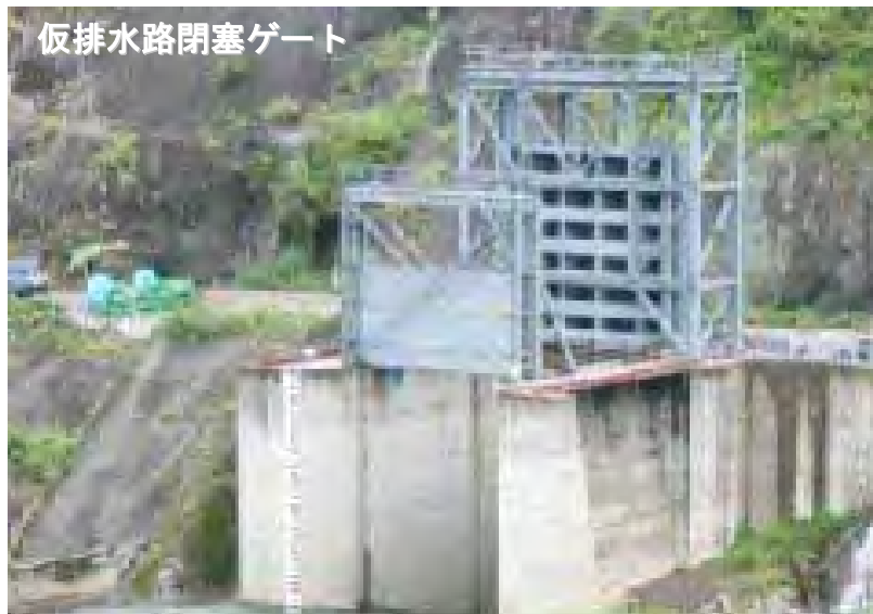
転流工閉塞状況写真（他ダム事例）
