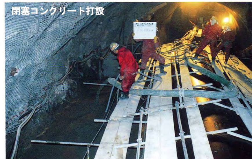
転流工閉塞状況写真（他ダム事例）
