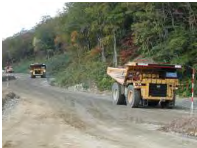
工事用道路写真(他ダム事例)
