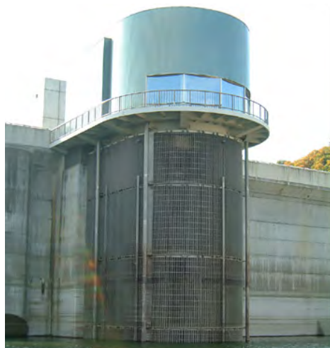
選択取水設備(他ダム事例)
