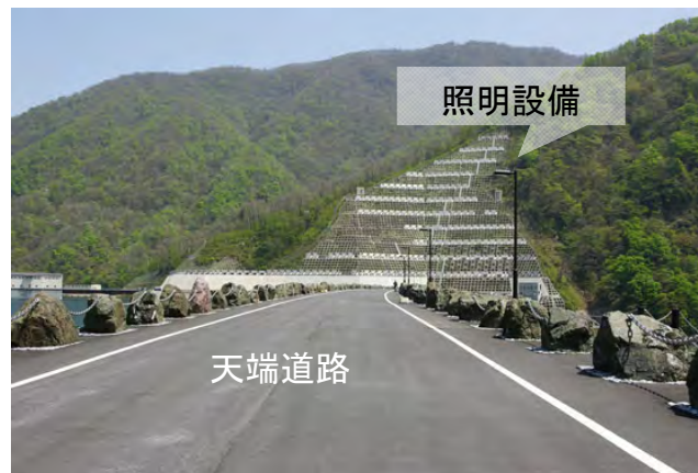
照明設備と天端道路(他ダム事例)
