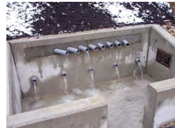
地すべり対策(他ダム事例)
