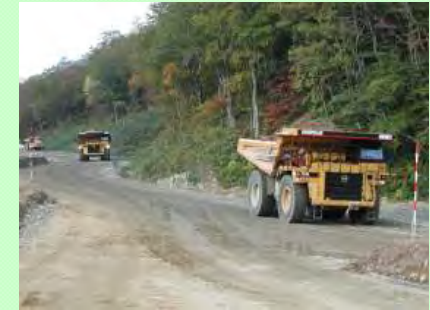
仮設工(工事用道路)
