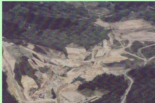
基礎掘削工(土石掘削、岩掘削等)
