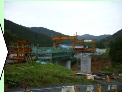
補償工事(付替道路)
