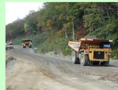
仮設工(工事用道路)
