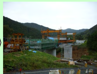
補償工事(付替道路)
