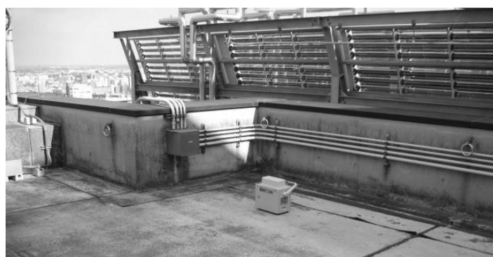
図1 可搬型モニタリングポスト設置状況
