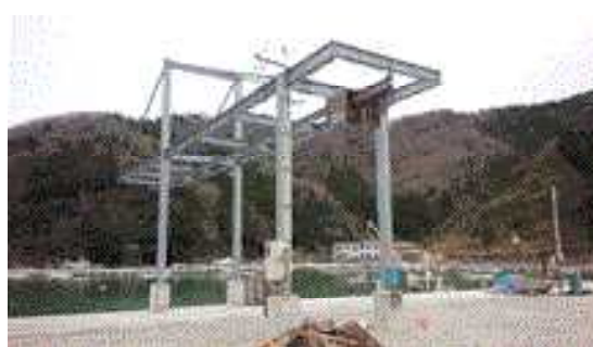
荷揚げクレーン
