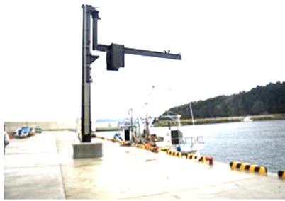
導入した荷揚げクレーン
