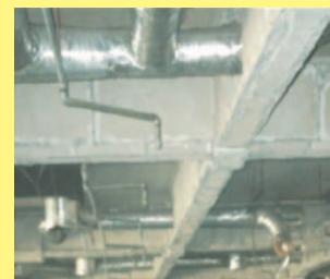
石綿含有耐火被覆材 (鉄骨の梁などの耐火被覆材)
