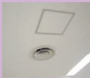
石綿含有ロックウール吸音天井板
