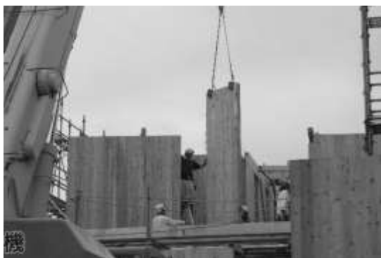
図 32：CLT を用いた建築物の建設風景 画像出典：宮城県 林業振興課
