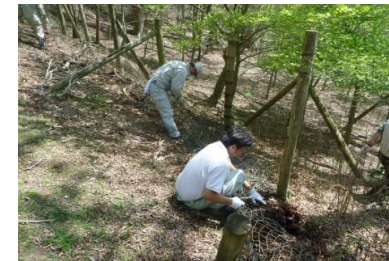
防鹿柵のネット撤去が完了した状況
