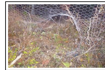
破損した防鹿柵
