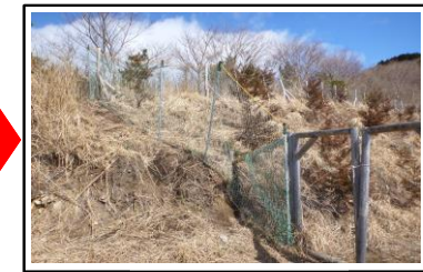
補修後の防鹿柵
