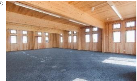
CLTを用いた木造建築物（多賀城市内）
