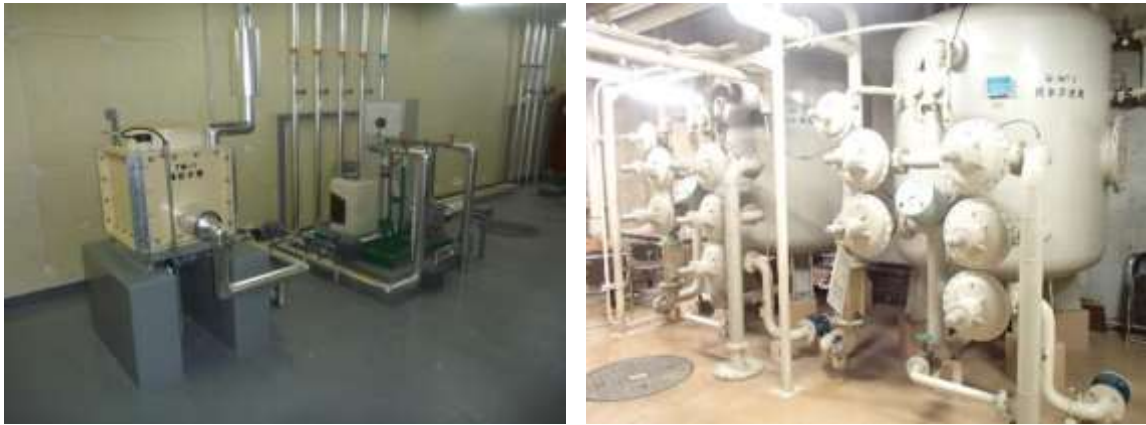
写真 5.1 雨水利用の取組事例 (雨水利用システム, 左: 宮城県保健環境センター, 右: 宮城県庁)
