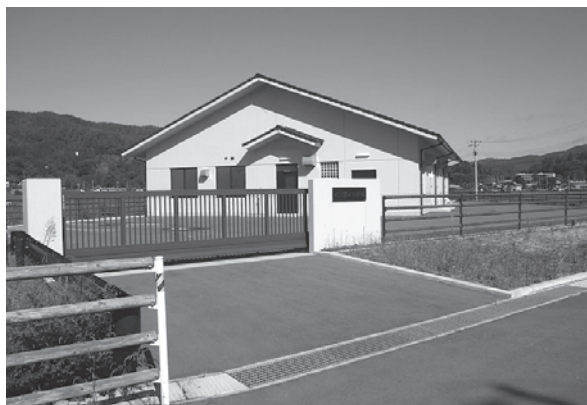
▲米川地区汚水処理施設（登米市）
