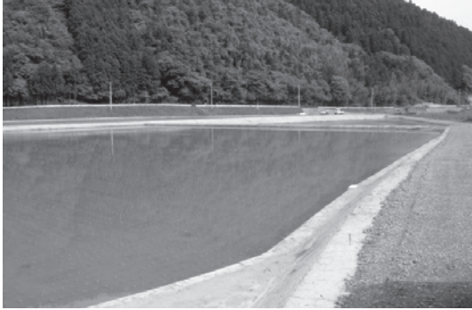
▲ほ場整備・東和地区（登米市）
