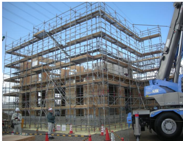
[CLTを用いた木造建築物(多賀城市内)]
