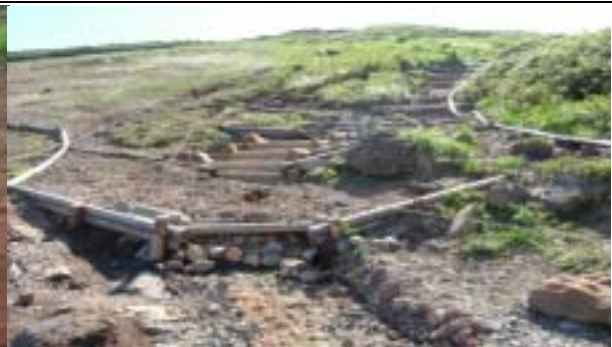
栗駒国定公園 (雪田植生復元対策工事)
