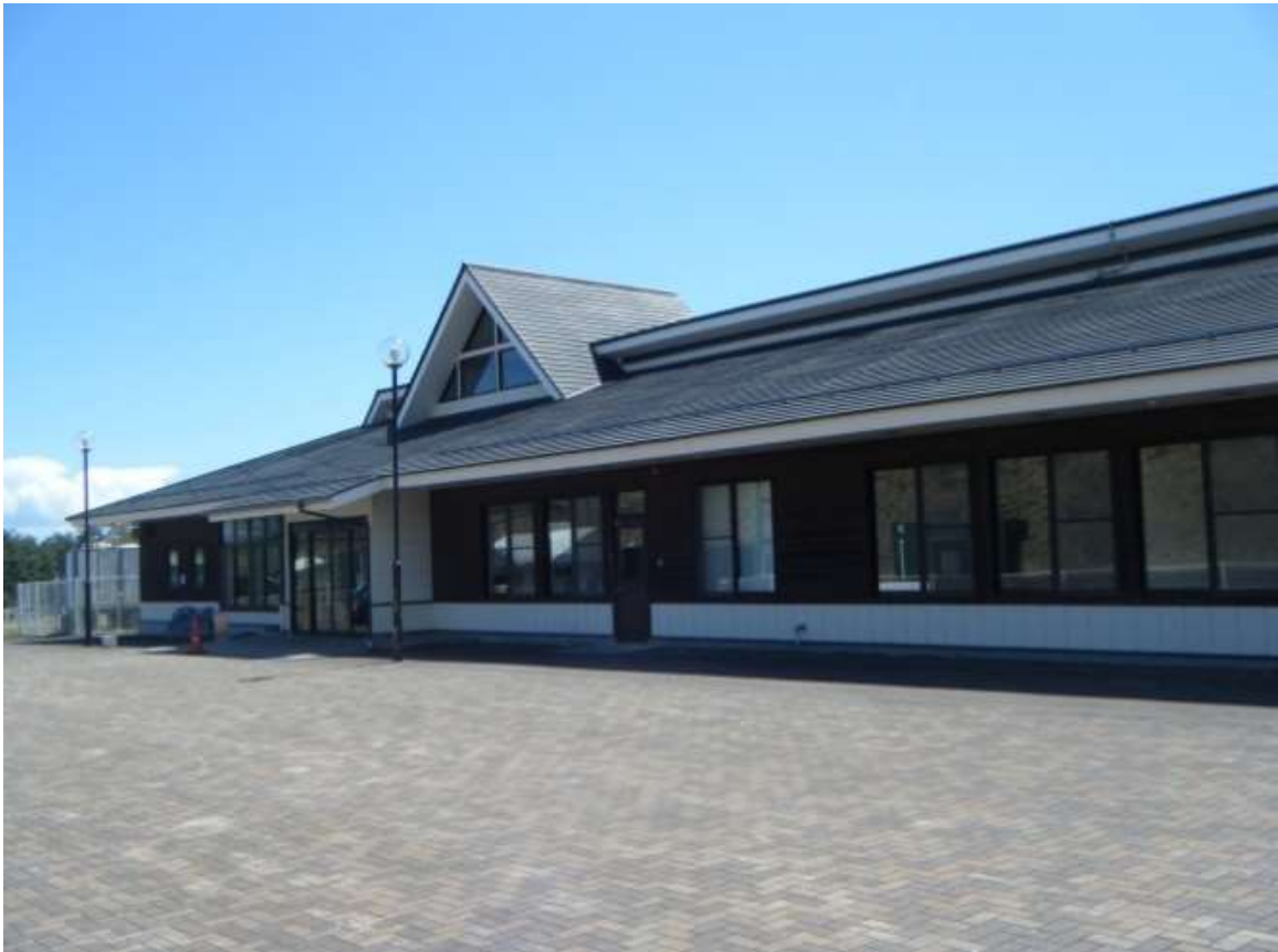
写真 1 宮城県クレー射撃場外観
