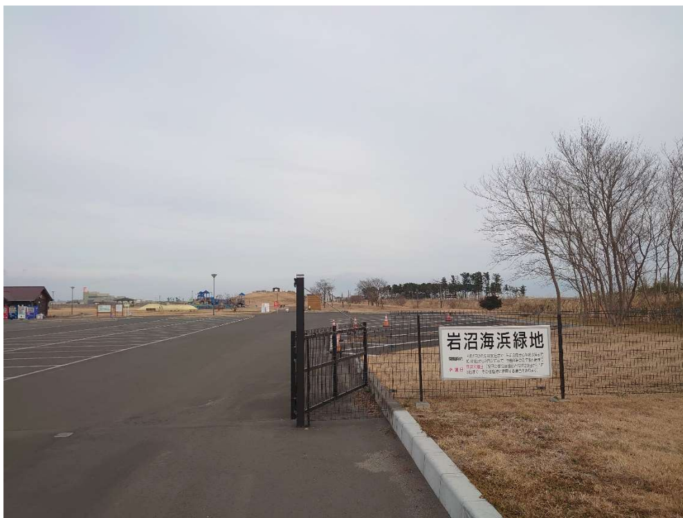
写真 4 岩沼海浜緑地南ブロックの入口の様子
