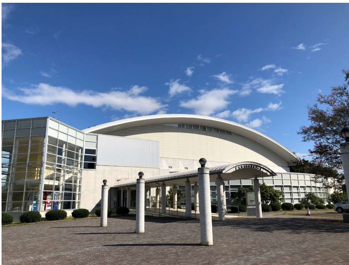
写真 1 宮城県仙南総合プール外観
