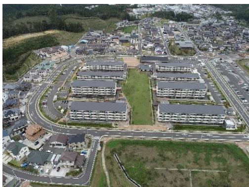
福祉交流施設を併設している南三陸町の災害公営住宅（志津川東地区）
