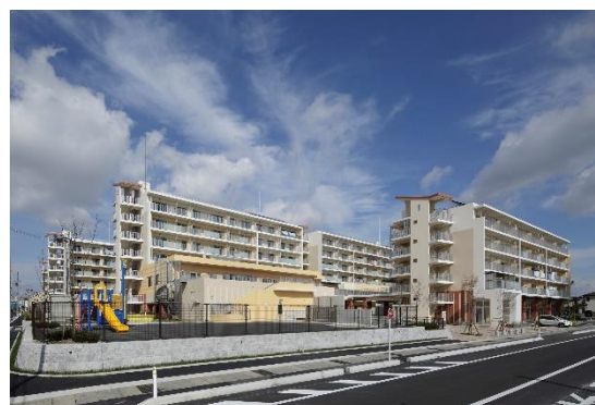
多賀城市営災害公営住宅（桜木地区）
