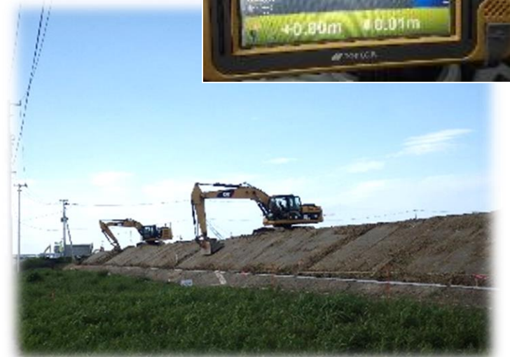
3DMG搭載のバックホウ による法面整形
