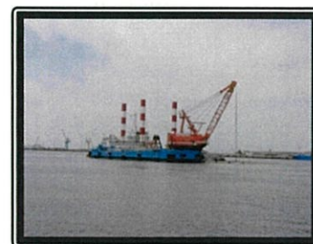
施工状況: グラブ浚渫
