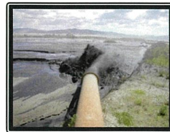
施工状況: 排砂管吐き出口
