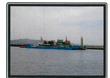
施工状況: 揚土土捨
