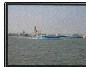
施工状況: 土運船運搬
