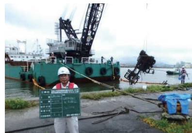
支障物の撤去
