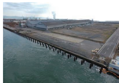
打ち込み完了
