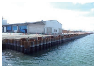
締め切り完了
