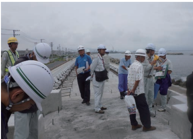
西浜防潮堤（平成29(2017)年9月6日）
