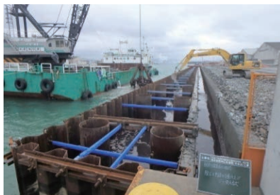
割石投入作業
