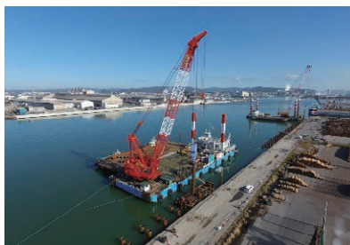
打ち込み作業
