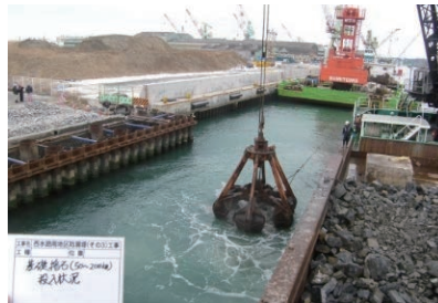
石投入の様子
