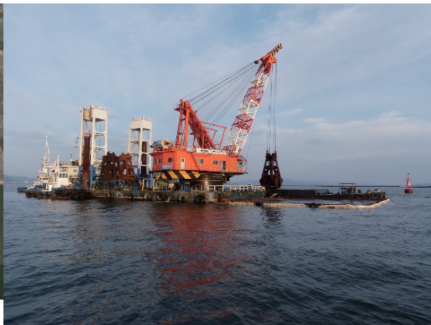
雲雀野地区航路・泊地(-13m) 浚渫工事(国)
