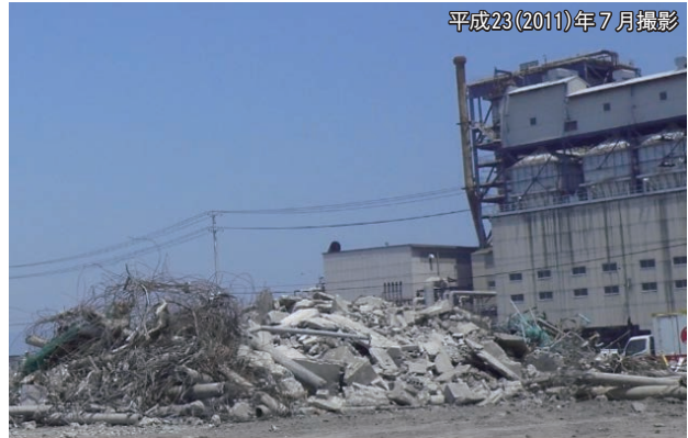
⑦潮見埠頭(港内啓開瓦礫)
