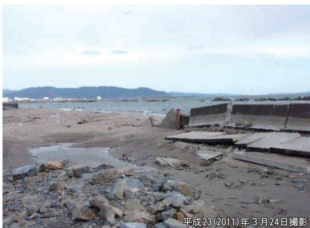
平成23(2011)年3月14日撮影 公共岸壁の沈下、流出した津波漂流物の状況
