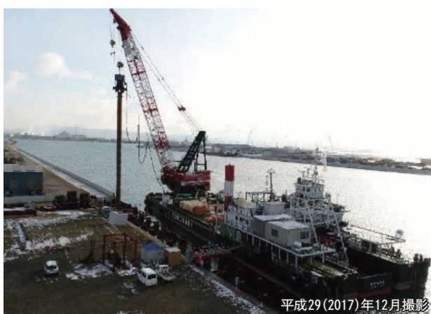
施工中の西水路北地区防潮堤
