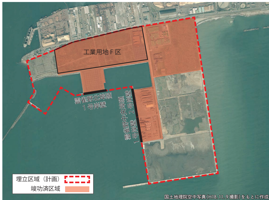
雲雀野中央埠頭2号岸壁、北埠頭1号岸壁の完成
