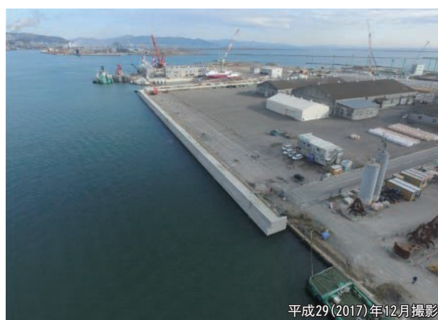
施工中の西水路南地区防潮堤
