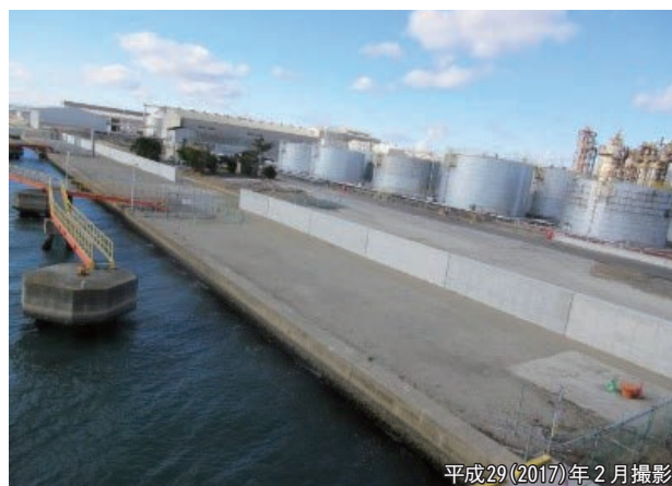
一部完成した西水路北地区防潮堤
