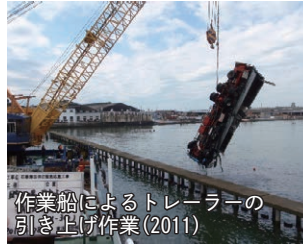
作業船による荷役機械の引き上げ作業(2011)
